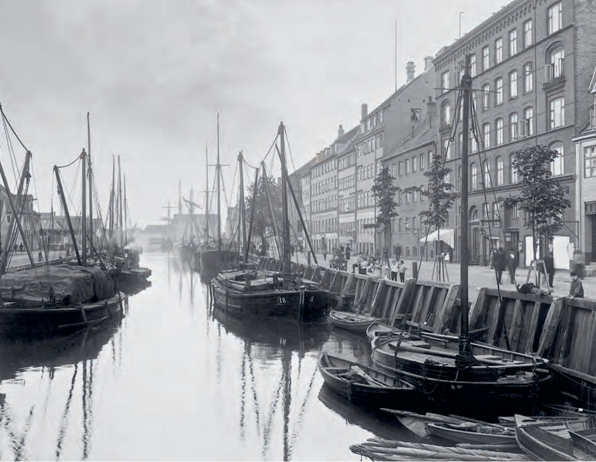
Fartøjer i Christianshavns Kanal 1887. I forgrunden ligger et par pramme nr. 17 og 18 med to master. Som det ses er de forsynede med lossebomme og på hver mast en løs sprydstage beregnet til at sætte smakkesejl. Kbh.billeder.
